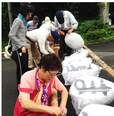
アーチ組み立ての様子
