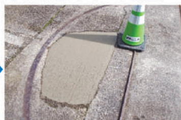
共同作業所丹波本所(須知)の出入りのコンクリート補修。
