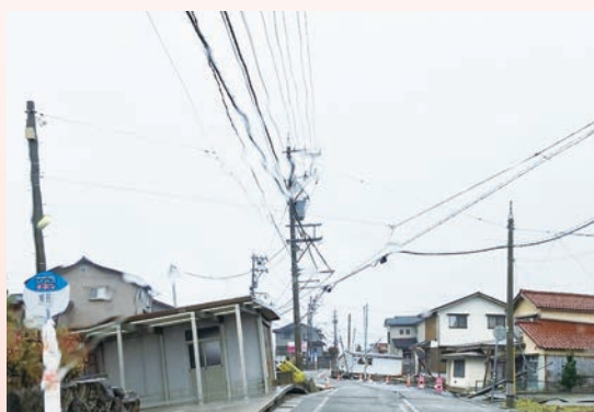
能登半島地震による被害（電柱の倒壊） 提供：京都府災害ボランティアセンター
