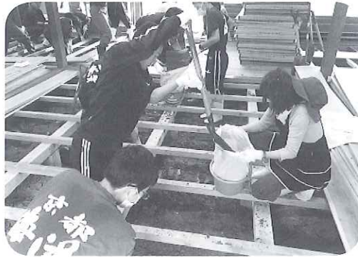
宮津市災害ボランティアセンターの活動
